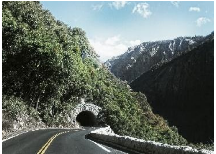
La technologie de Tunnel Sensors installée dans plus d'une centaine de tunnels à travers le monde, comme dans le tunnel du Mont-Blanc
